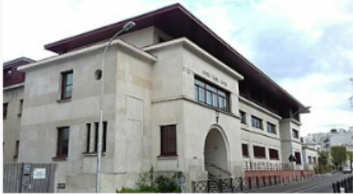
Lycée construit en 1930 Bâtiment inscrit à l'inventaire général du patrimoine culturel
